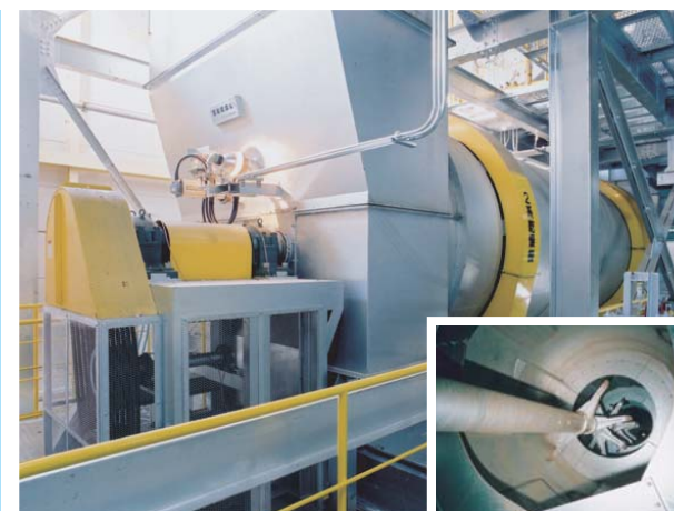
乾燥機 熱風によりごみを所定の水分以下に乾燥させます。
