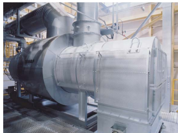
熱風炉 ごみ乾燥用の熱風を発生させ、乾燥機に送り込みます。
