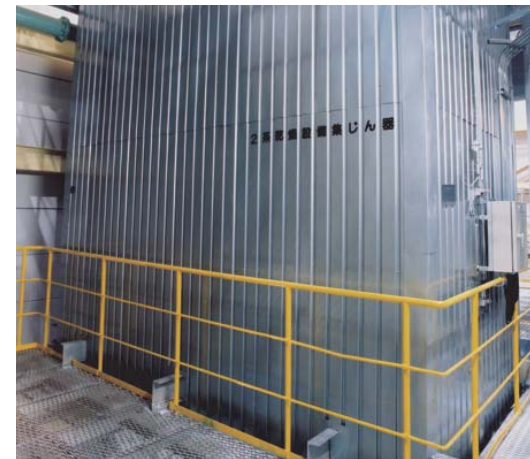
排ガス集じん器 排ガスに含まれる有害ガス、粉じんを除去します。
